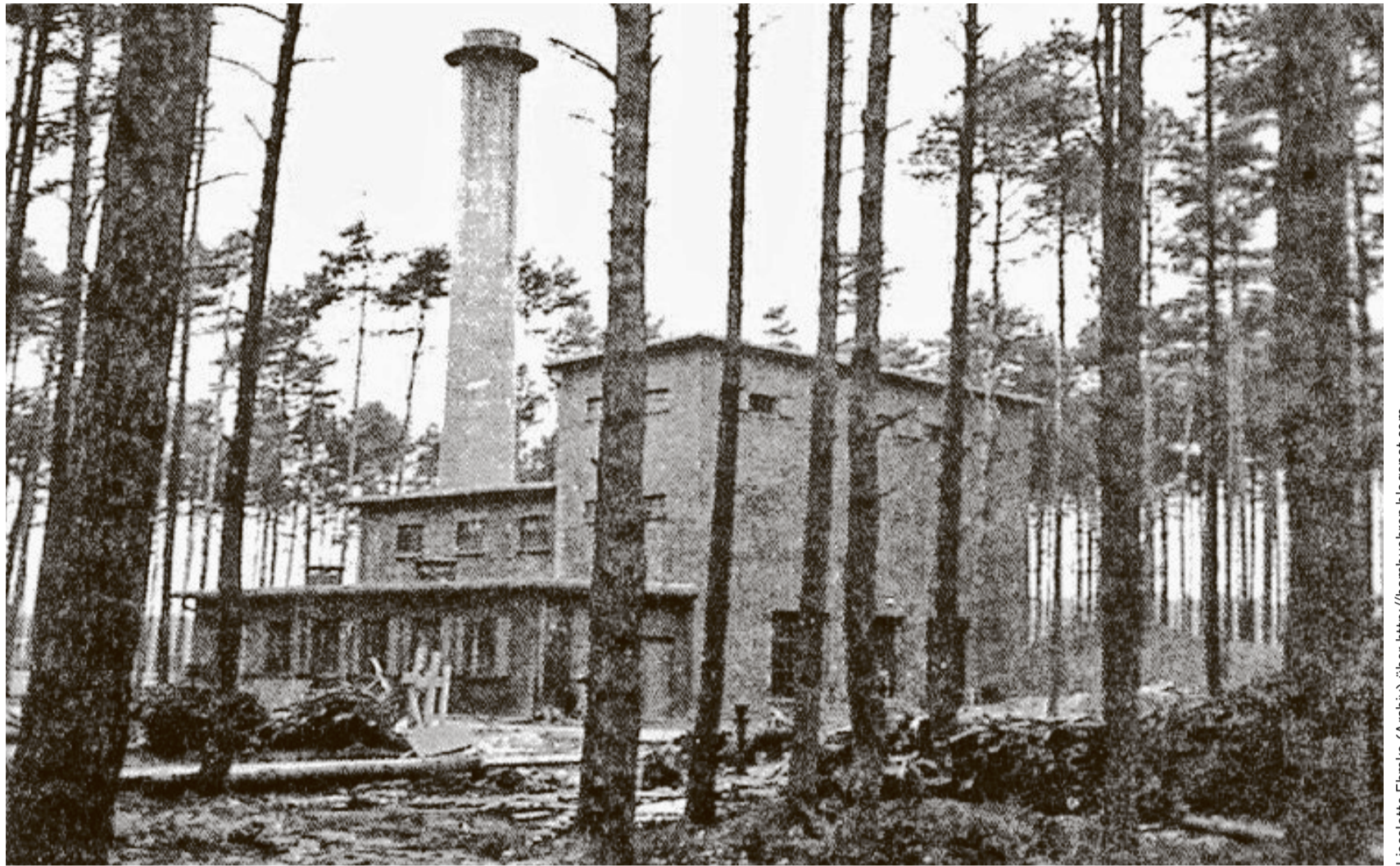
Die Heizzentrale in der Füllanlage 1 der Lufthauptmunitionsanstalt Hambühren.
